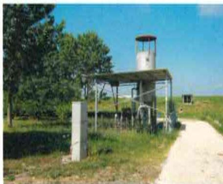
FIG. 6.2. Torcia asservita all'impianto di recupero energetico del biogas proveniente dai lotti B+C.
